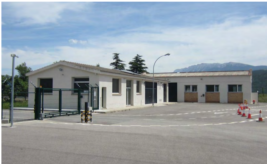
Figura 82. Edifici polivalent (esquerre) i edifici del SSEI (dreta)
