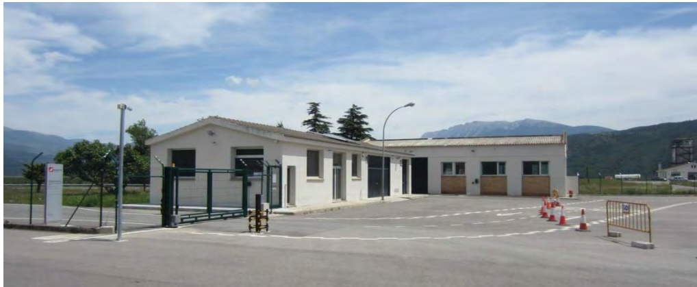
Figura 9. Edifici polivalent (esquerra) i edifici de primera intervenció (dreta)
