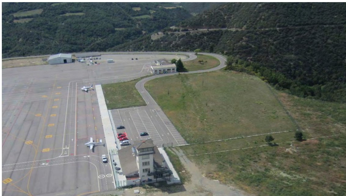
Figura 89. Accés a les instal·lacions aeroportuàries pel costat nord de la plataforma, i pàrquing de vehicles
