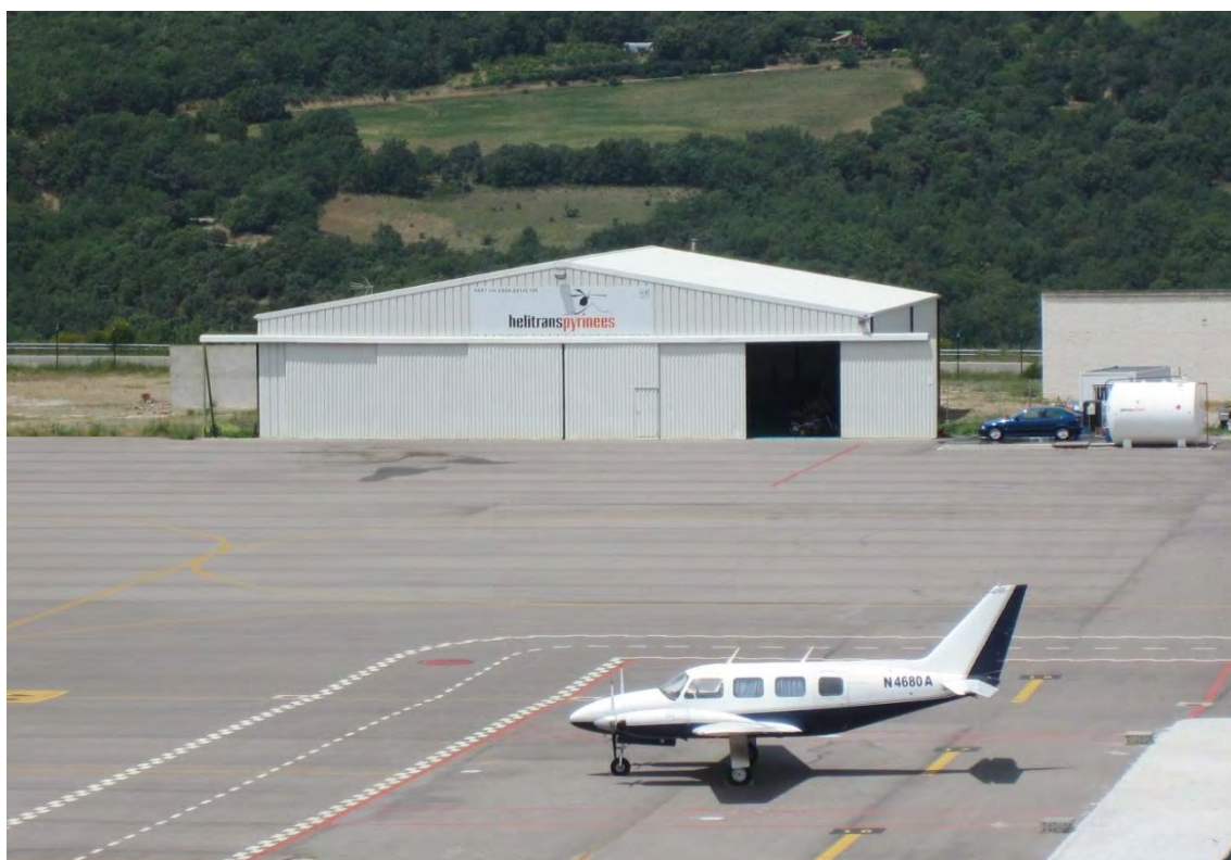
Figura 81. Hangar d'Helitrans Pyrénées
