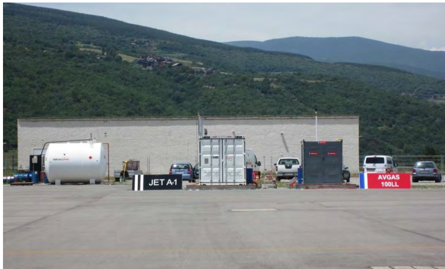
Figura 12. Dipòsits de combustible
