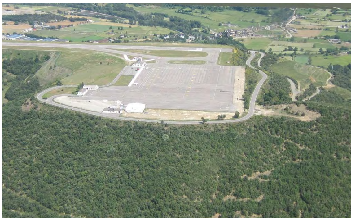
Figura 90. Vial d'accés a l'aeroport, que rodeja la plataforma
