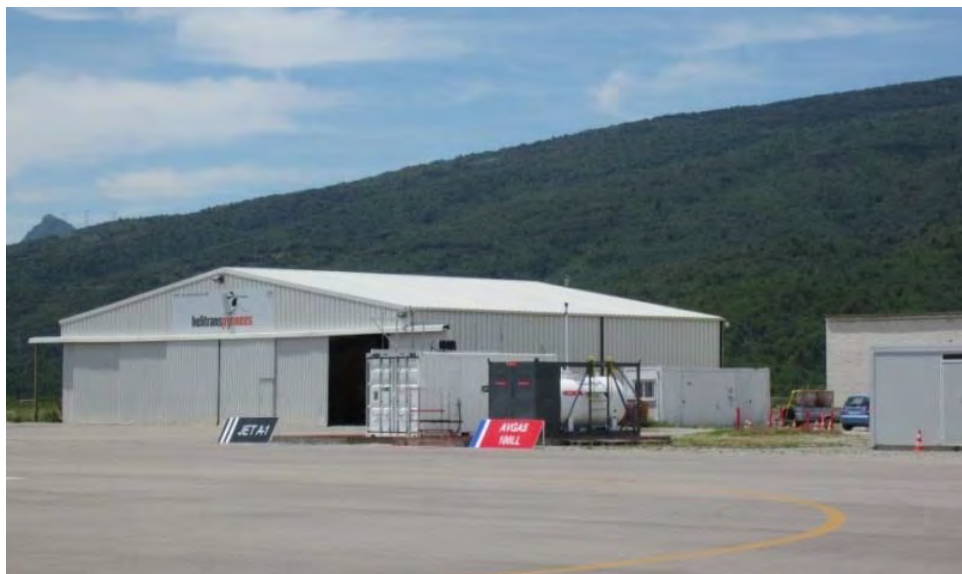
Figura 14. Hangar actual A-1
