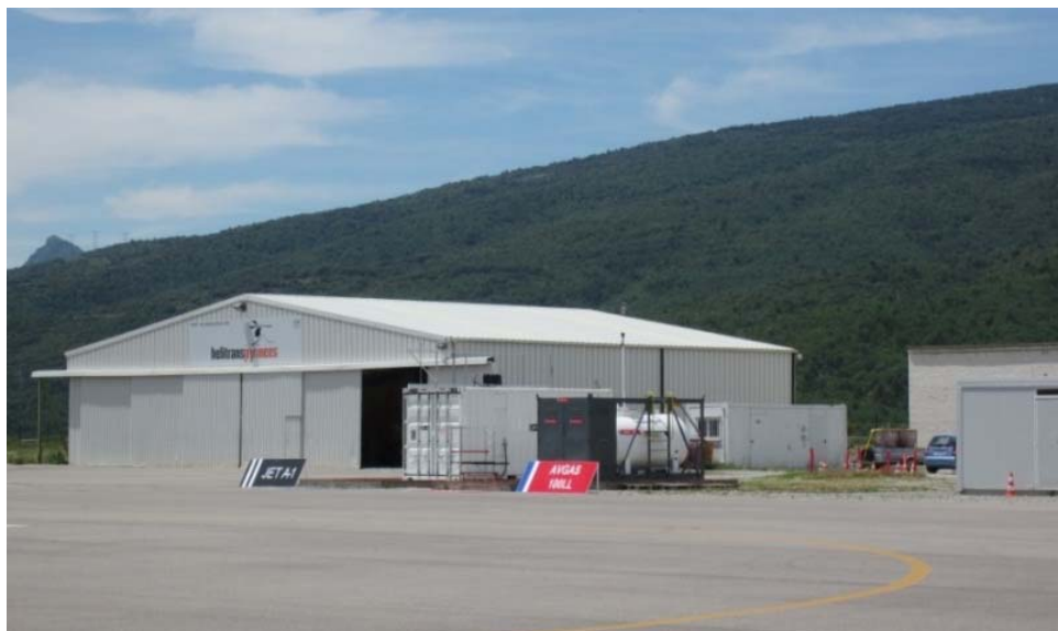
Figura 14. Hangar actual A-1
