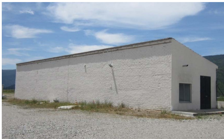
Figura 11. Edifici de la central elèctrica
