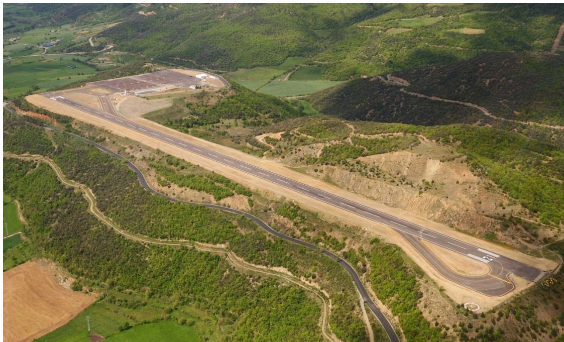
Figura 72. Vista aèria de l'aeroport i l'altiplà on està ubicat
