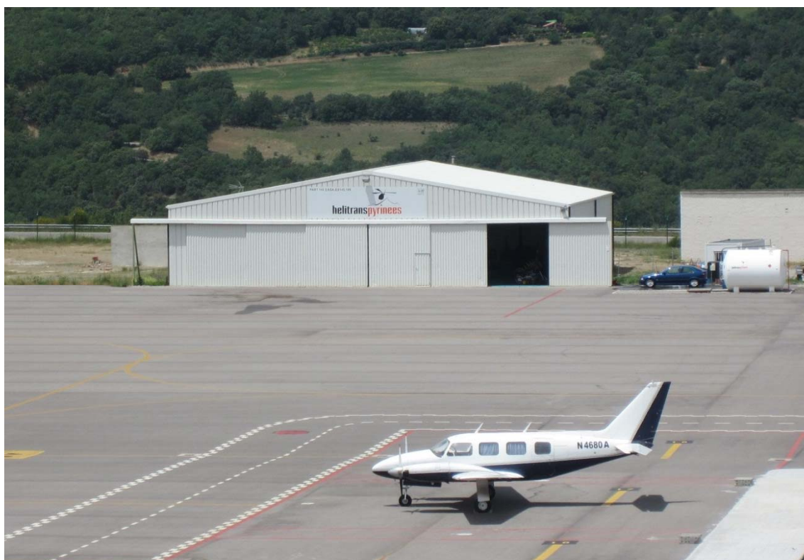
Figura 81. Hangar d'Helitrans Pyrénées
