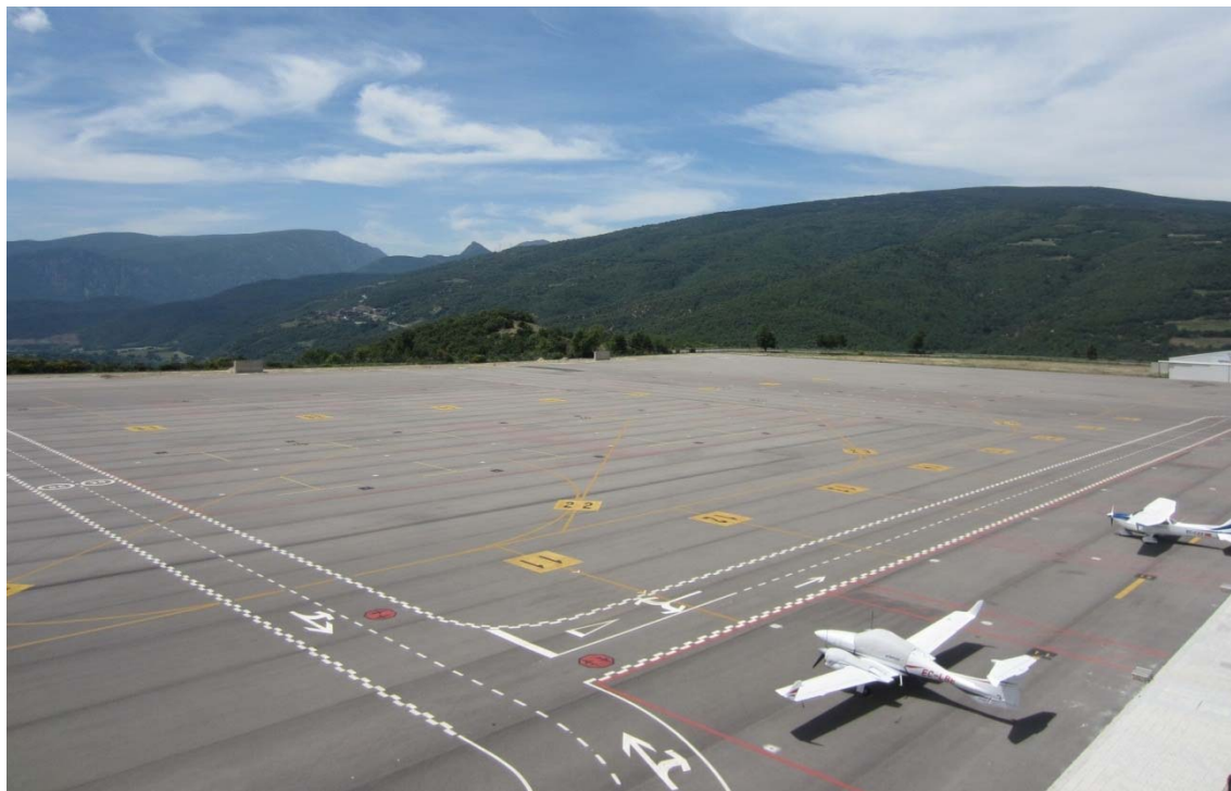
Figura 78. Plataforma estacionament d'aeronaus
