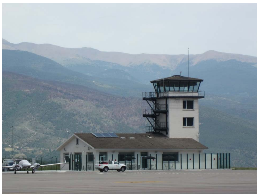
Figura 8. Edifici terminal i torre
