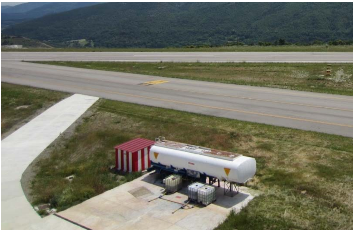
Figura 79. Plataforma de subministrament d'aigua per als Bombers
